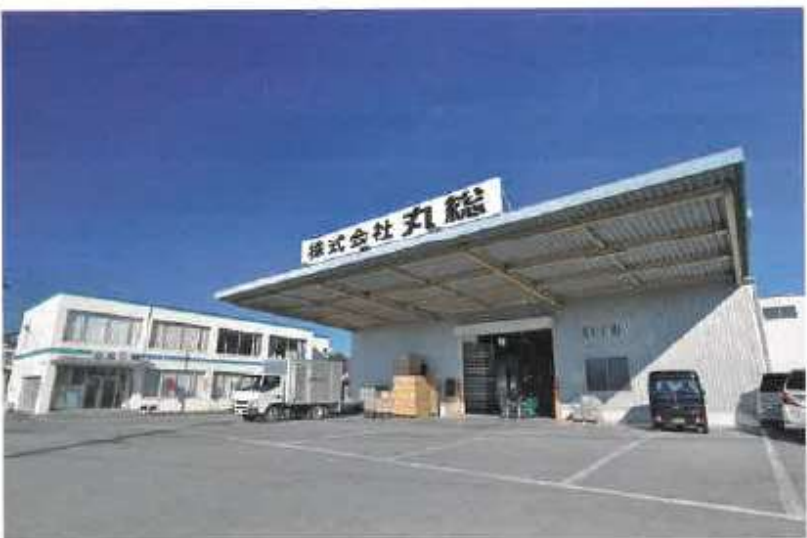
本社1号倉庫&社屋
